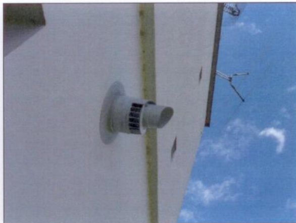
č. 8 Detail odvětrání lokálního topeniště
